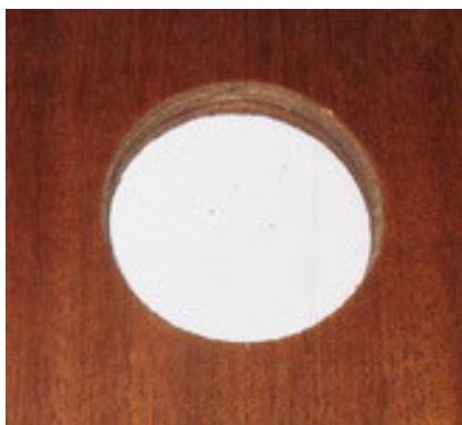
1. PORAA REIKÄSAHANTERÄLLÄ 52 mm ASENNUSREIKÄ.
